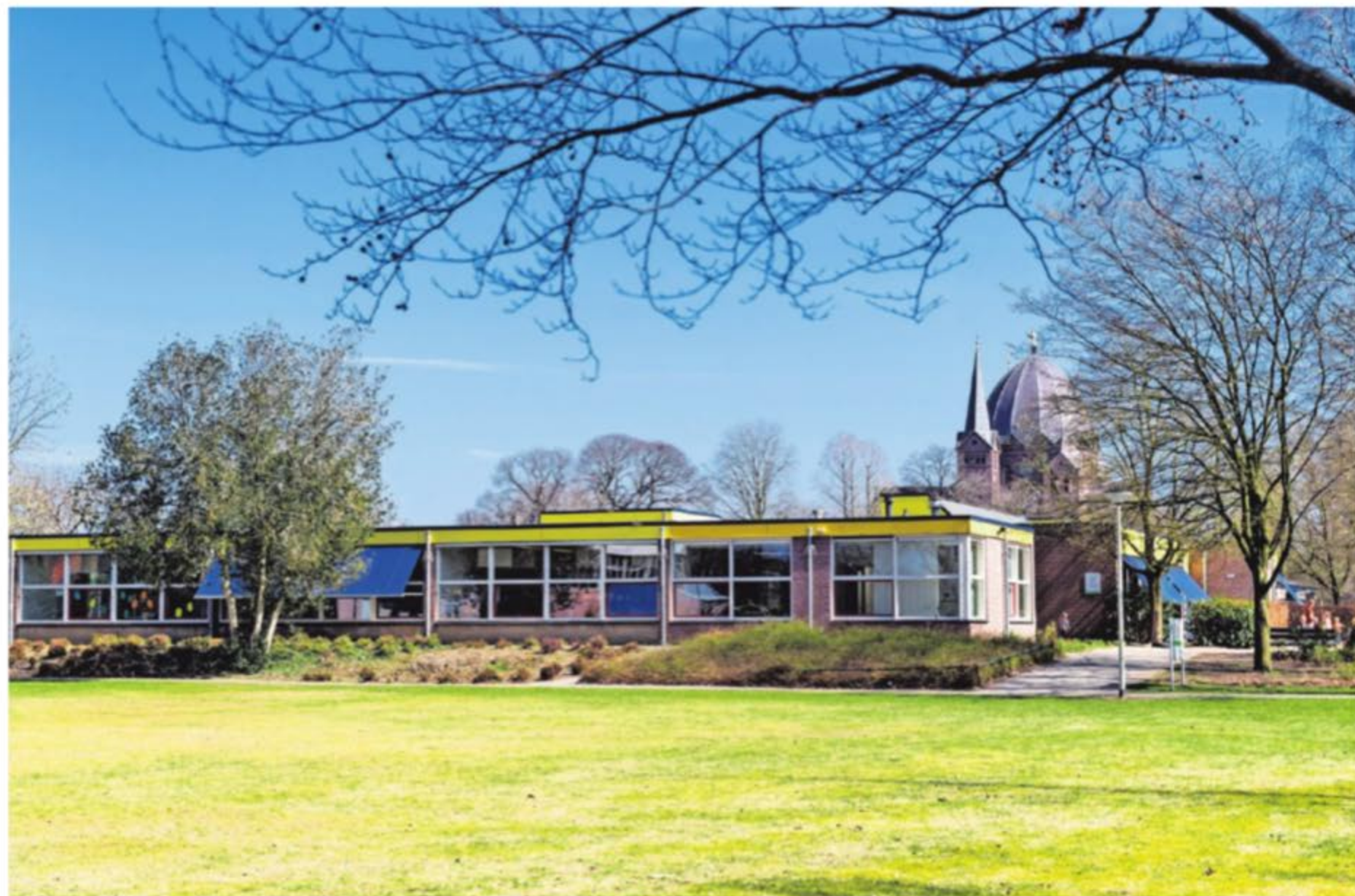
▲ De nieuwbouw van basisschool 't Rendal in Lierop staat er nog niet maar de bouwplannen worden toch al aangepast om vanwege het stijgende aantal geboorten ruimtetekort te voorkomen. FOTO JEAN PIERRE REIJNEN/DCI MEDIA
