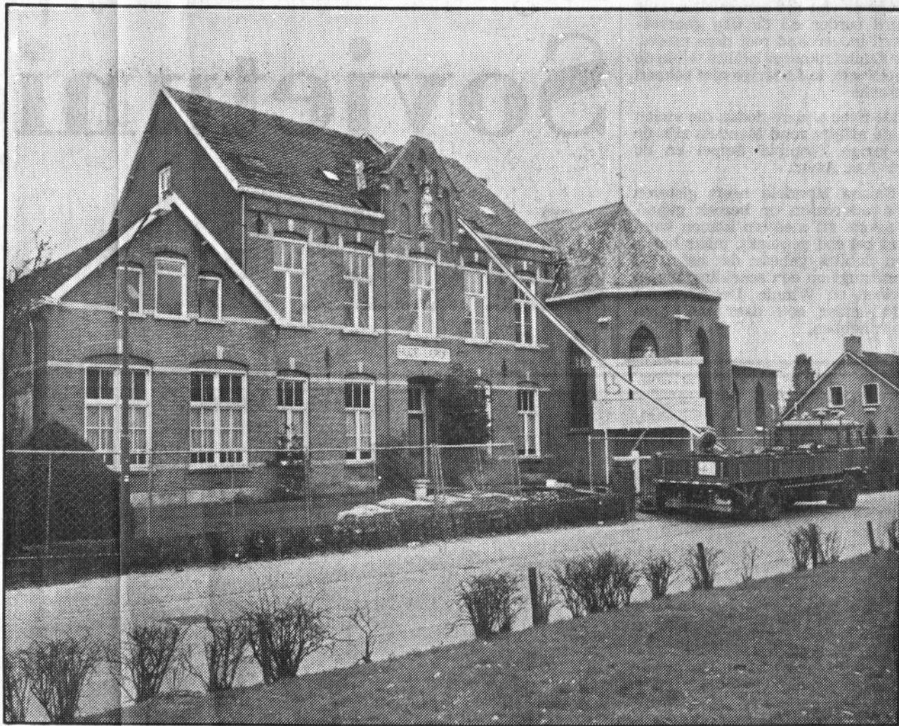
● Met het verwijderen van de dakpannen is gisteren de sloop van het oude klooster in Lierop begonnen.
