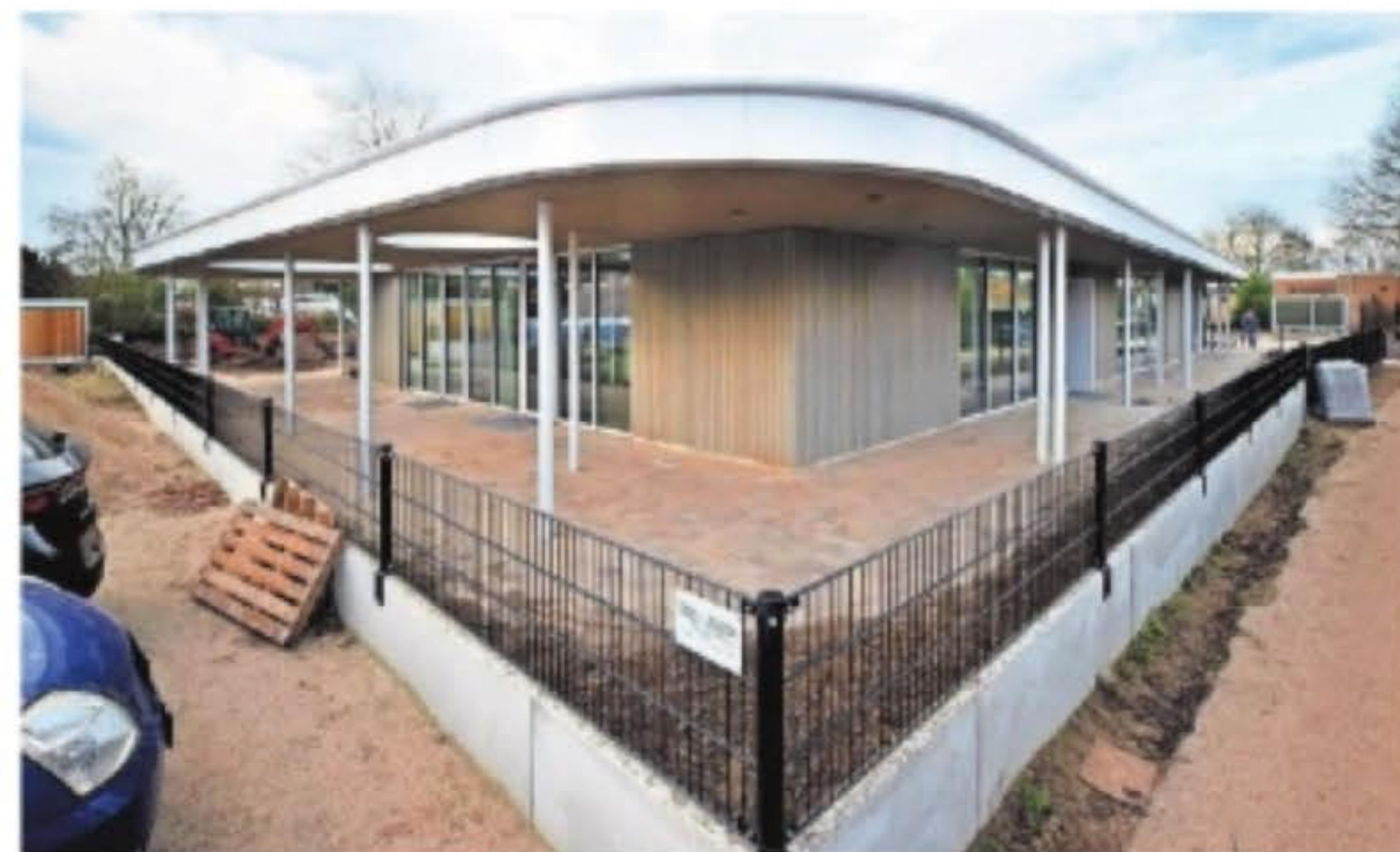
▲ 't Rendal vanaf de buitenkant gezien. Het gebouw kenmerkt zich door veel hout en glas.
